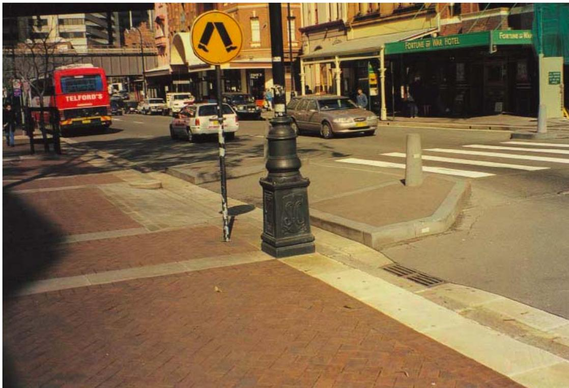
Foto 3: En el caso de que el vado se encuentre previamente bien ejecutado, se pueden instalar elementos fijos que invadan la franja de aparcamiento e impidan que los vehículos aparquen en el paso peatonal
