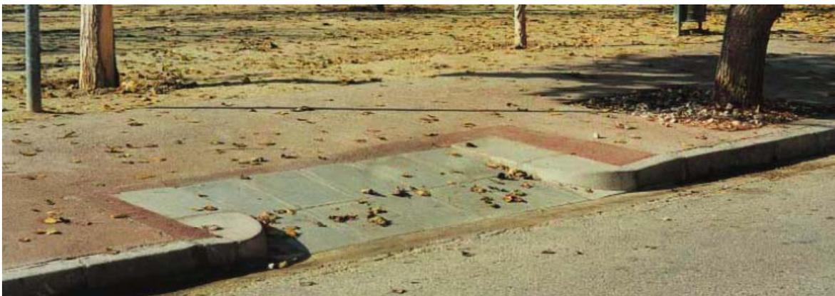
Foto 9: Vado de una rampa sin protección de cuchillos laterales
