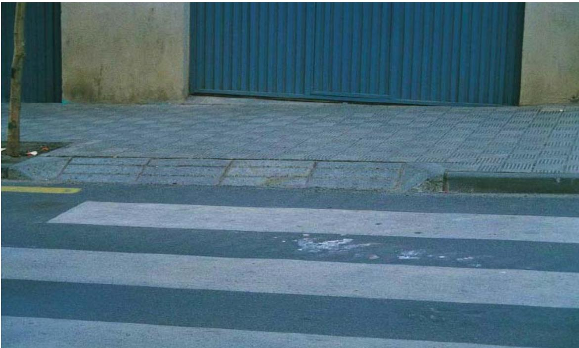
Foto 2: Vado para vehículos que no interfiere la circulación peatonal. No precisa la colocación de franjas señalizadoras de pavimento diferenciado. La señalización de paso de cebra no es adecuada en este caso, puesto que no se trata de un paso de peatones
