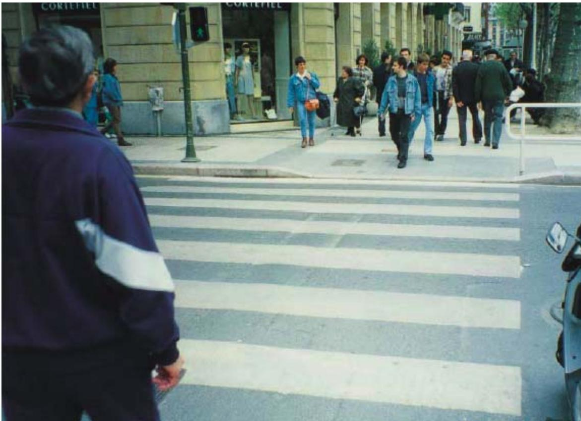
*Foto 2: Paso peatonal con buena ejecución de vado pero con señalización de paso de cebras mal situada y mal*
