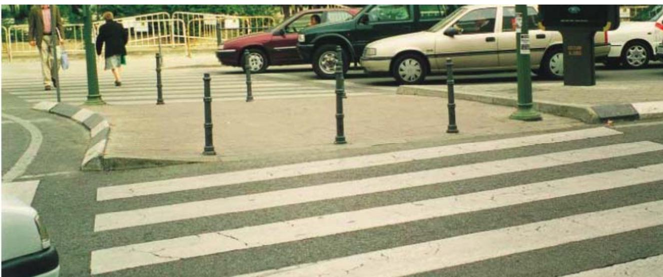
*Foto 3: Isleta con pavimento diferenciado en textura y color, y rebajada al nivel de la calzada. Los bolardos impiden que los vehículos invadan la isleta pero no son recomendables para las personas ciegas o con deficiencias visuales*
