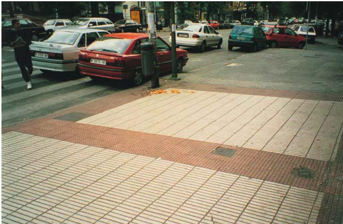
*Foto 8: Vado de tres rampas con dos bandas señalizadoras laterales, construido con "pavimento de botones" de color contrastado con el itinerario peatonal en que se ubica*
